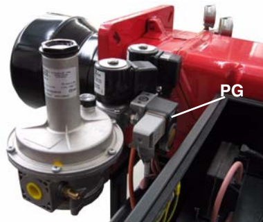
Рис. 22 - Реле давления газа
