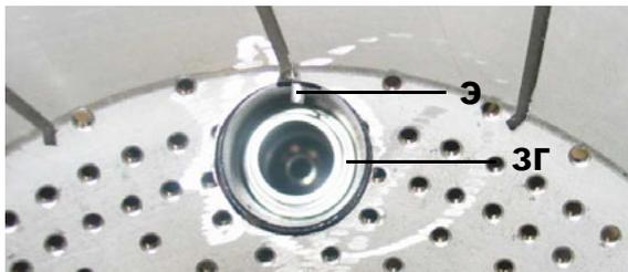
Рис. 29 - Часть диффузора с запальной горелкой (P) и запальным электродом (E).
