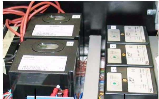
(A1) SIEMENS LFL... (A2) SIEMENS LAL..
