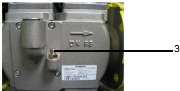
3 = подсоединение (3) трубки от рампы запальной горелки к клапанной группе основной газовой рампы
