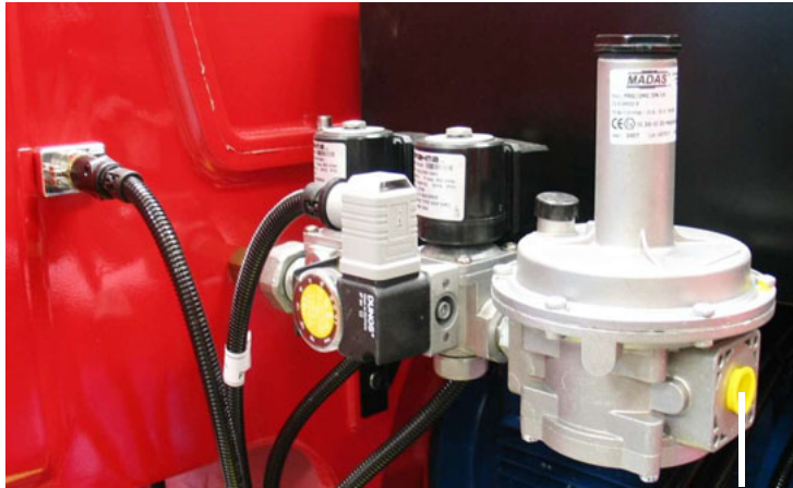
подсоединение к сети распределения газа
