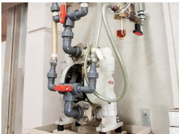
FDM Выкачивание химического никеля для гальванической ванны.
