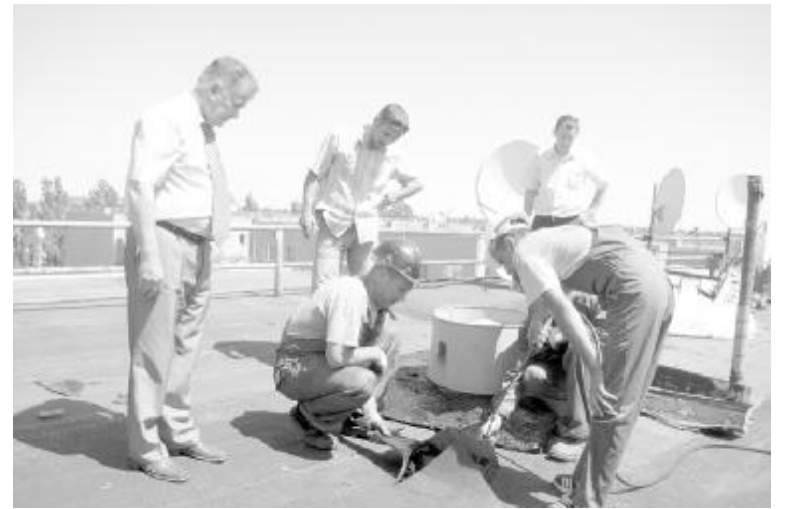
Н. Перепечин осматривает состояние кровли д.12 по ул. Э. Тельмана.
