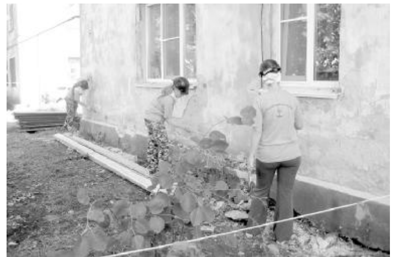
На ремонте д.3 по ул. Строительной – рабочие ООО «Ремстроймонтаж».
