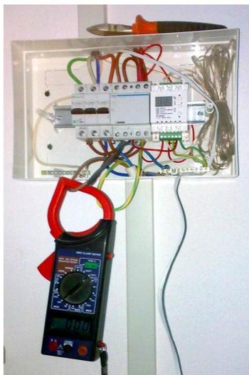
Замер показателя силы тока производится амперметром (мультиметром) клещевым по нагрузке на «фазном» проводе (на каждой из фаз, при 380V) .
