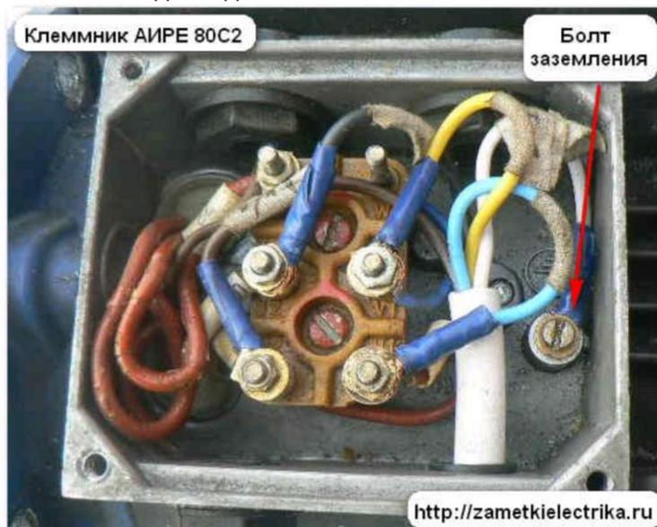
Чтобы подключить двигатель в прямом направлении, нужно подать переменное напряжение  $\sim 220$  (В) на клеммы W2 и V1, а переключки поставить, как показано на картинке ниже, т.е. между клемм U1-W2 и V1-U2.
