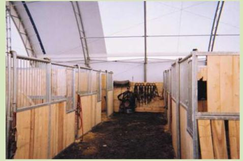
Ангар состоит из металлокаркаса и натянутого поверх тентового материала, придающего всему сооружению прочность монолитной конструкции.
