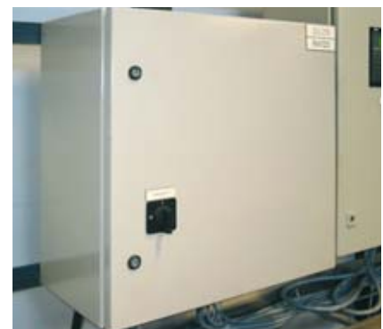
Силовой шкаф РК100
