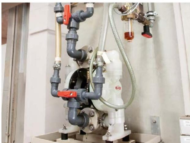
FDM Выкачивание химического никеля для гальванической ванны.
